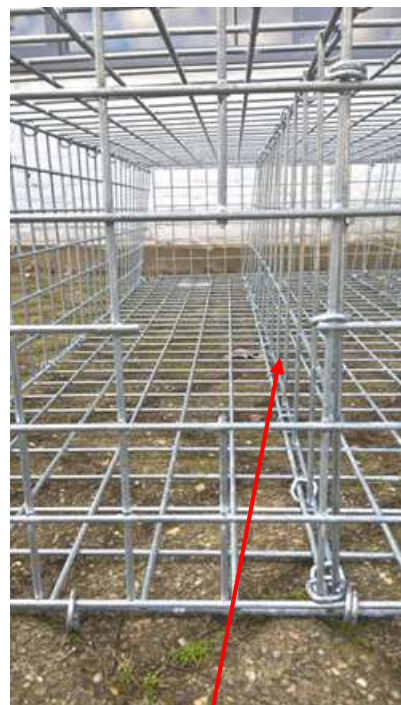
Grille intérieure de stabilité du gabion
